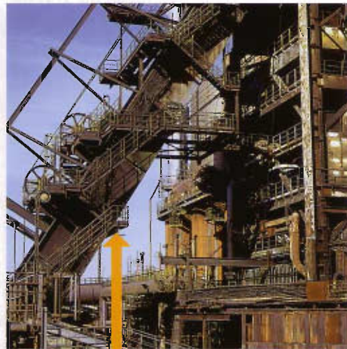
monte-charge incliné du haut fourneau B
